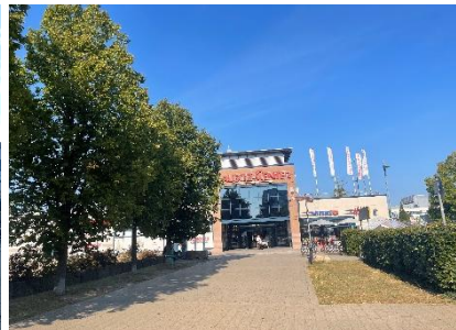
Lausitz-Center, Zugang über Parkplatz
