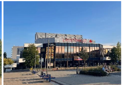
Lausitzhalle Hoyerswerda, Lausitzer Platz
